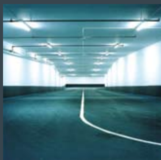
Подземные парковки • Выбросы углекислого газа • Удары • Влажность
